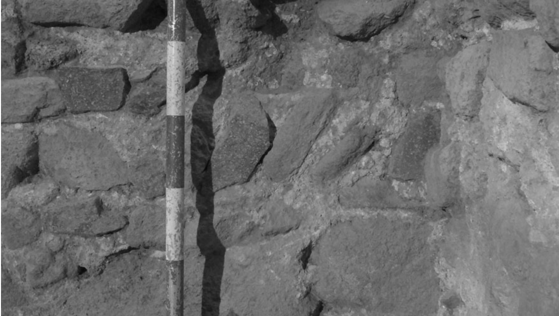
Figura 5 Exemple de pseudo opus spicatum d'encofrat. [Fotografia: Ramon Coll]
